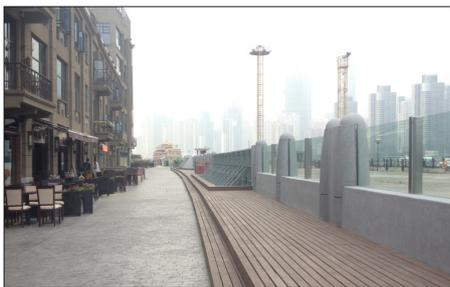
图18 钢化玻璃防汛墙效果图
